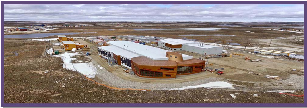
Construction de la Station canadienne de recherche dans l'Extrême-Arctique, Cambridge Bay, NU
